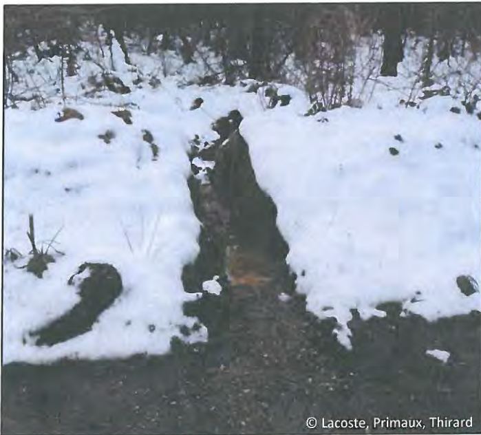
Figure 41 - Aménagement pour guider les écoulements depuis le sentier vers la forêt du cap d'Ailly
