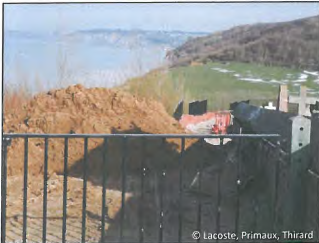
Figure 32 - Travaux de protection du cimetière marin de l'église de Varengeville-sur-Mer
