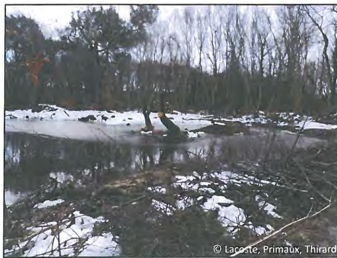
Figure 37 - Travaux d'entretien et de réouverture d'une mare sur la site du Cap d'Ailly
