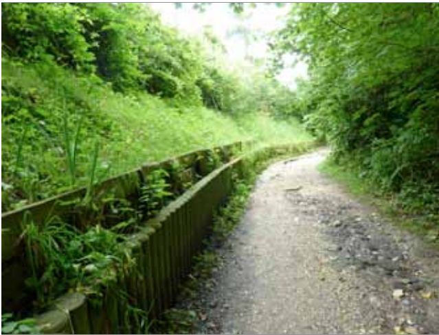
▲ Soutènement des pieds de versants par des madriers et des poteaux bois
