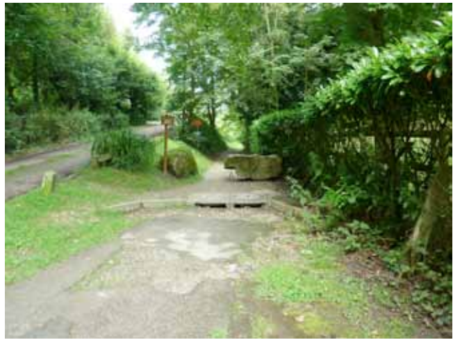
▲ Départ du chemin piéton. Dépôts de matériaux accumulés
