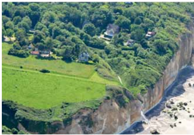
▲ Vue aérienne de la valleuse de Vasterival
