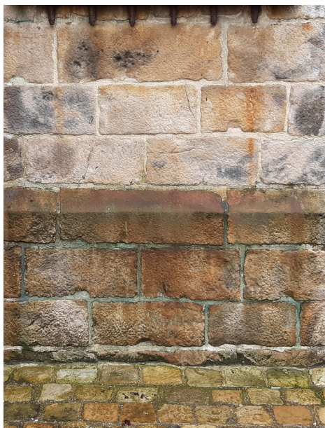
exemple des pierres à nettoyer par abrasion
