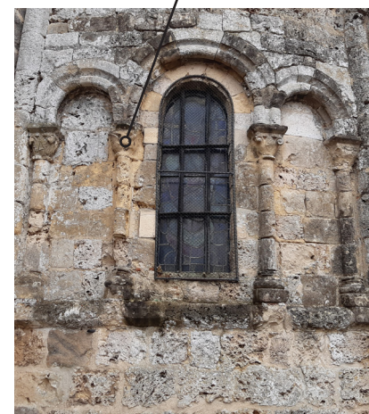
pilastres et modénatures du chevet
