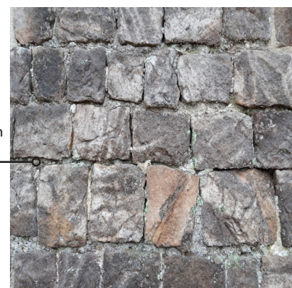
Détail de la façade nord du collatéral.
